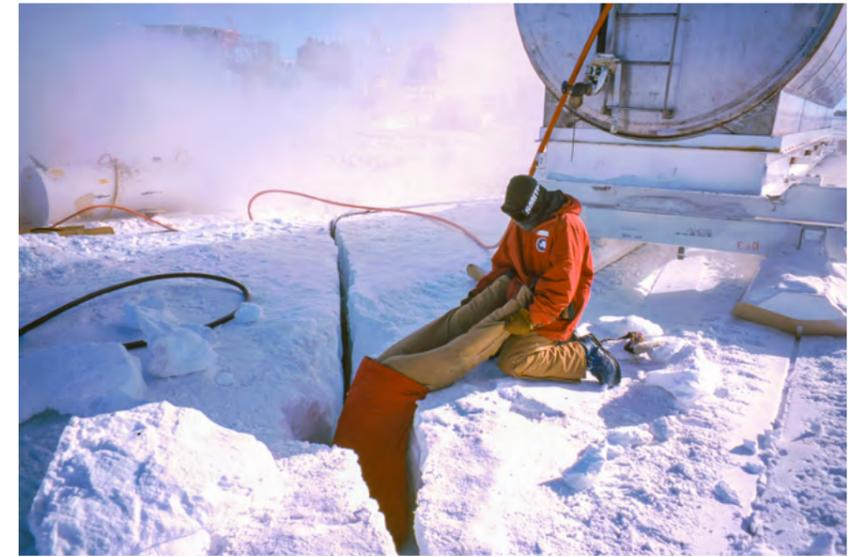
Für den Neutrino-Detektor AMANDA werden Lichtsensor-Kabel tief ins Eis verlegt.
